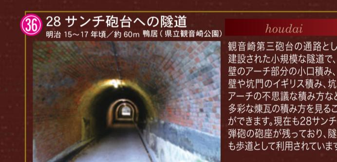
観音崎第三砲台の通路として建設された小規模な隧道で、内壁のアーチ部分の小窓み、側壁や坑門のイギリス積み、坑門アーチの不思議な構みなど、多彩な磚瓦の積み方を見ることができます。現在も28サンチ榴弾砲の砲座があり、隧道は信号機による交通整理でその役目を果たしています。
