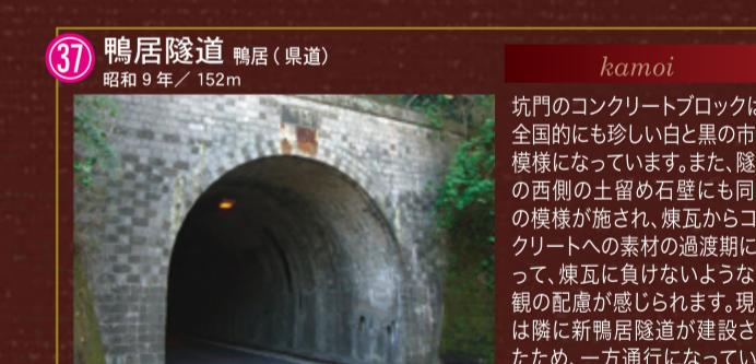
坑門のコンクリートブロックは、全國的に珍しい白と黒の市松模様になっています。また、隧道の西側の土留め石壁にも同様の模様で施され、煉瓦からコンクリートへの素掘過渡部にあって、煉瓦に負けないような美しい配色が感じられます。現在は隣に新鶴居隧道が建設されたため、一方通行となっています。
