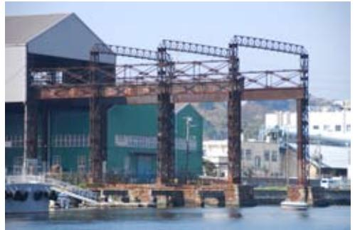
ガントリークレーンとは港湾の岸壁に設置され、コンテナなどの貨物の積み卸しを行うクレーンのことを言います。長浦港埠頭にあるガントリークレーンは関東大震災以前に作られたとされ、現在は海上自衛隊横須賀造修所により使用されています。
