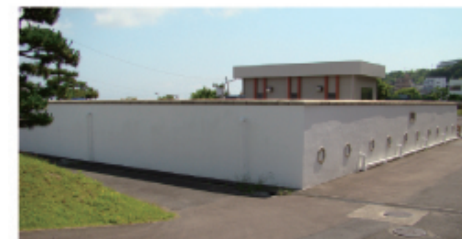
鉄筋コンクリート造浄水池
