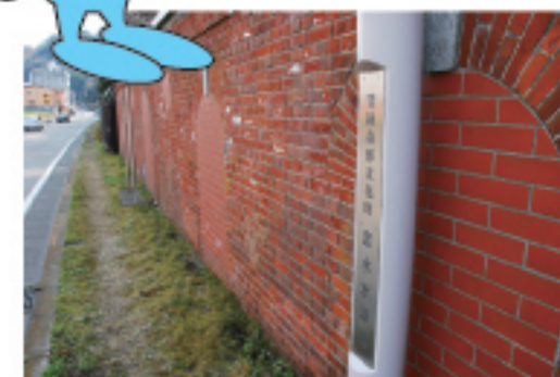
煉瓦造貯水池
