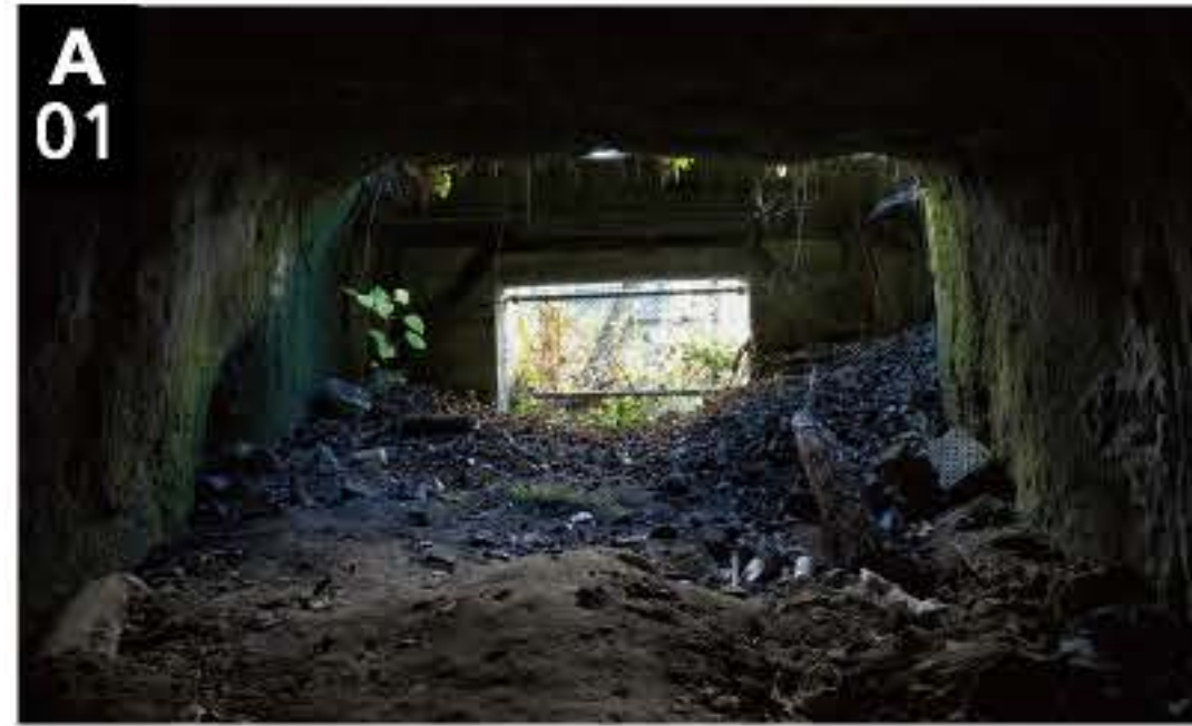
A 01 貝山地下壕 Kaiyama Underground Vault 横須賀市浦郷町5-2931-63
