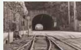
比与宇隧道は、終戦まで軍用引き込み線の隧道でした。隧道内では、列車からの弾薬の積み降ろしが行われていました。このため、線路と車道が並ぶ珍しい隧道でしたが、現在は、隧道内の線路は撤去されています。また、比与宇隧道からJR田浦駅に向かう道路沿いには、線路同士が直角に平面交差する、全国でも珍しいポイントがあります。
